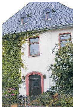
Im ehemaligen Pfarrhaus in Bietzen wird das Mehrgenerationenhaus entstehen, das jetzt Gestalt annimmt. Fotos: SZ
